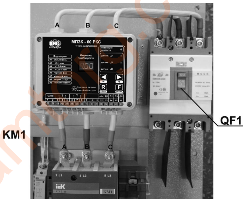
Фото 1. Подключение силовых проводников
