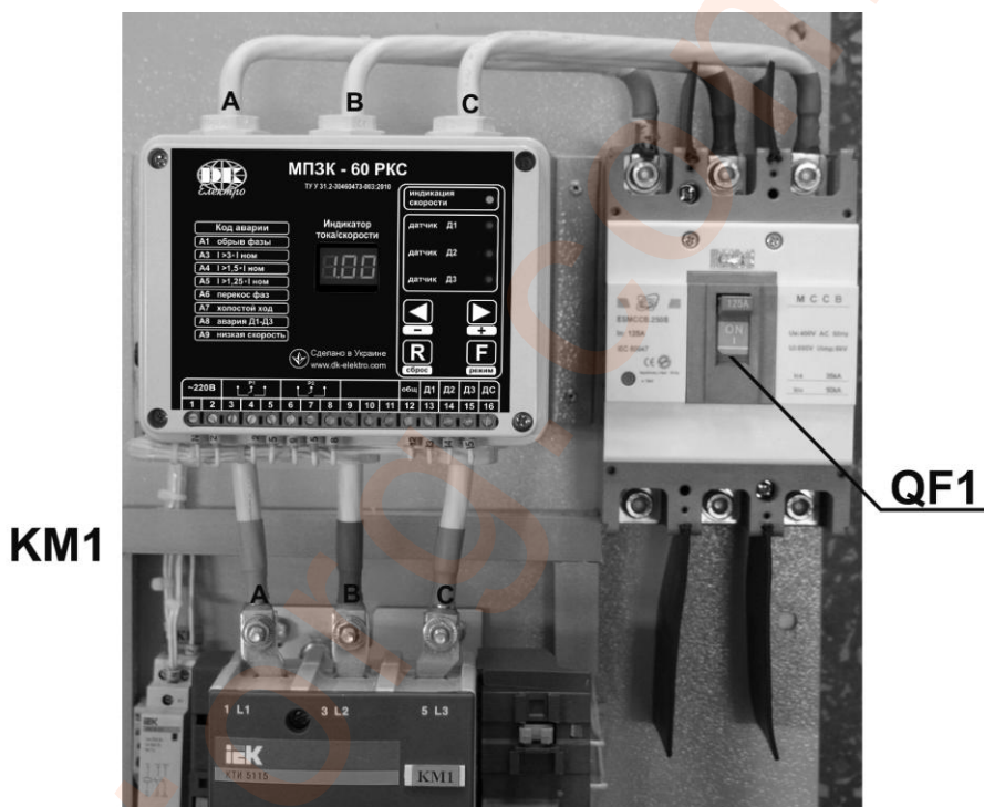
Фото 1. Подключение силовых проводников
